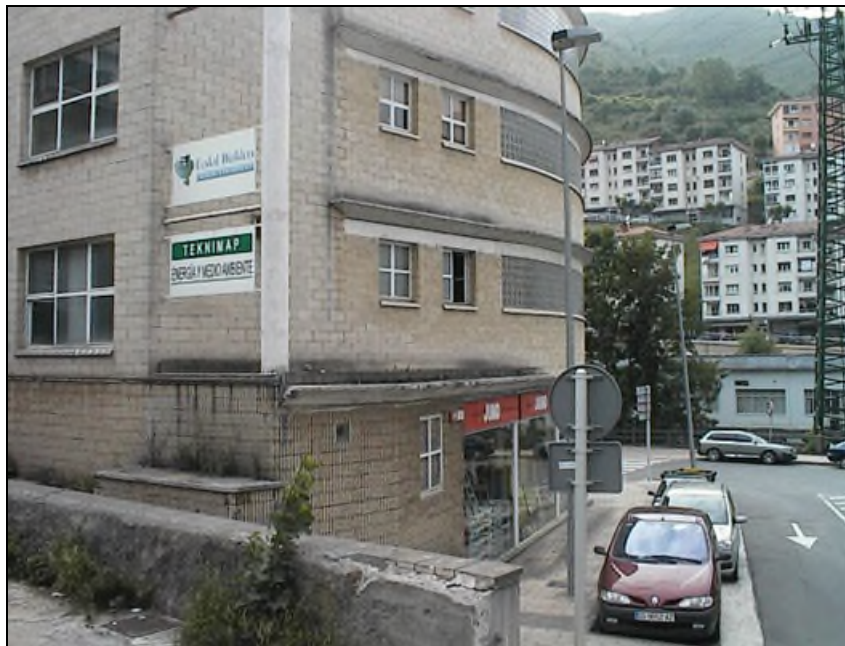
Foto del edificio donde se localizan las oficinas de TEKNIMAP Energía y Medio Ambiente
